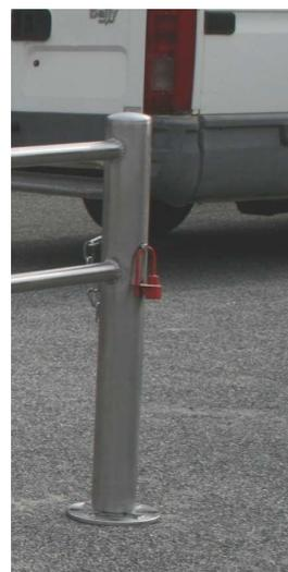
Fermeture sur le poteau principal par tige traversante et cadenas pompier
