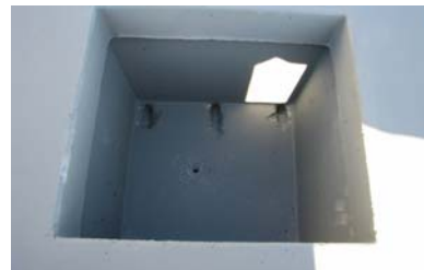
Détail foyer avec trous de tirage
