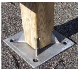
Détail platine de portique
