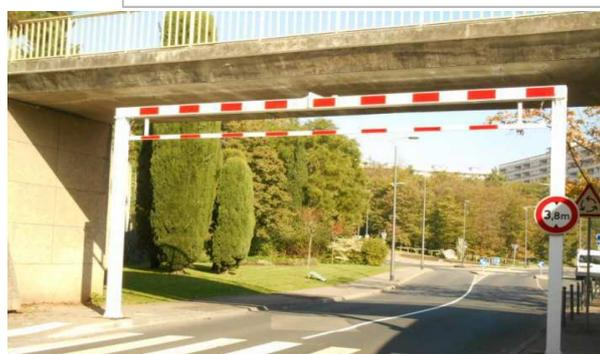
Portique avec option bavette simple et panneau limiteur de hauteur et support panneau
