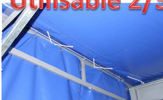
Fixation bâche toit
