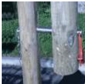
BLOCAGE DU POTEAU PIVOTANT PAR TIGE TRAVERSANTE ET CADENAS CLE TRIANGLE (Option)
