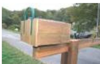
Détail boîtier de contrepoids Blocage de la barrière en position fermée
