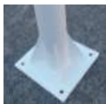
Platine de 500x500 Ep 15 mm
