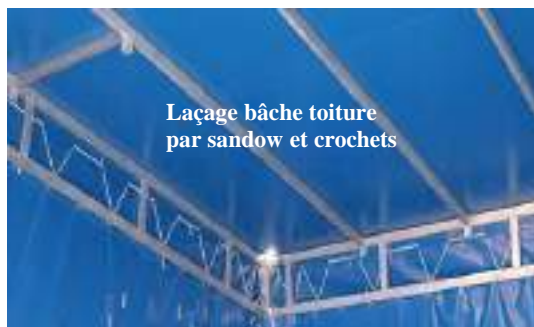
Schéma représentant l'ossature toiture adaptée sur la base du podium
