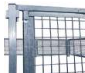
Garde corps grillagé conforme aux nouvelles normes obligatoires au dessus d'1 m et 0.09 du plancher (plus de sécurité enfants).
