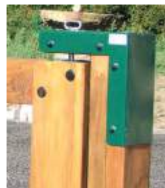
Renfort métallique protection tige traversante
