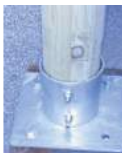
PLATINE DE FIXATION DES POTEAUX AU SOL
