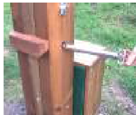
Blocage de la barrière S/ Poteau principal en position ouverte
